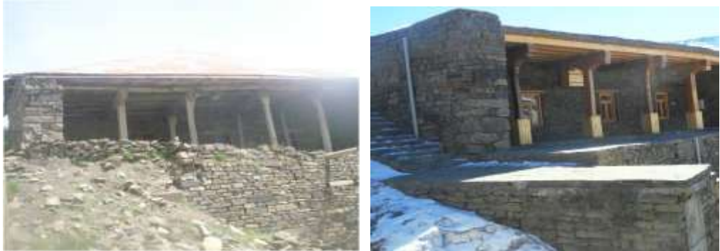
Şəkil 5. Quba rayonu, Xınalıq kəndi, Əbu-Müslüm məscidi bərpadan əvvəl və bərpadan sonra
